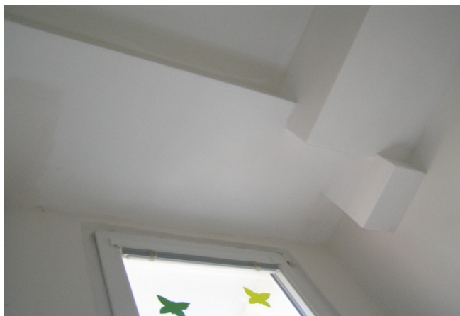
Příklad provedeního zakrytování ZTI rozvodů SDK instalačními kastlíky (Pavilon 1)
