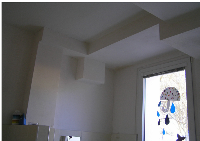
Příklad provedeního zakrytování ZTI rozvodů SDK instalačními kastlíky (Pavilon 1)
