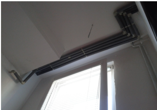
Foto - příklad současného provedení ZTI rozvodů pod stropy
