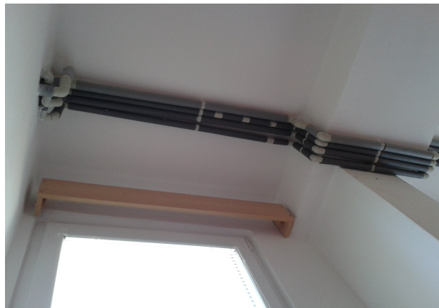
Příklad provedeního zakrytování ZTI rozvodů SDK instalačními kastlíky (Pavilon 1)
